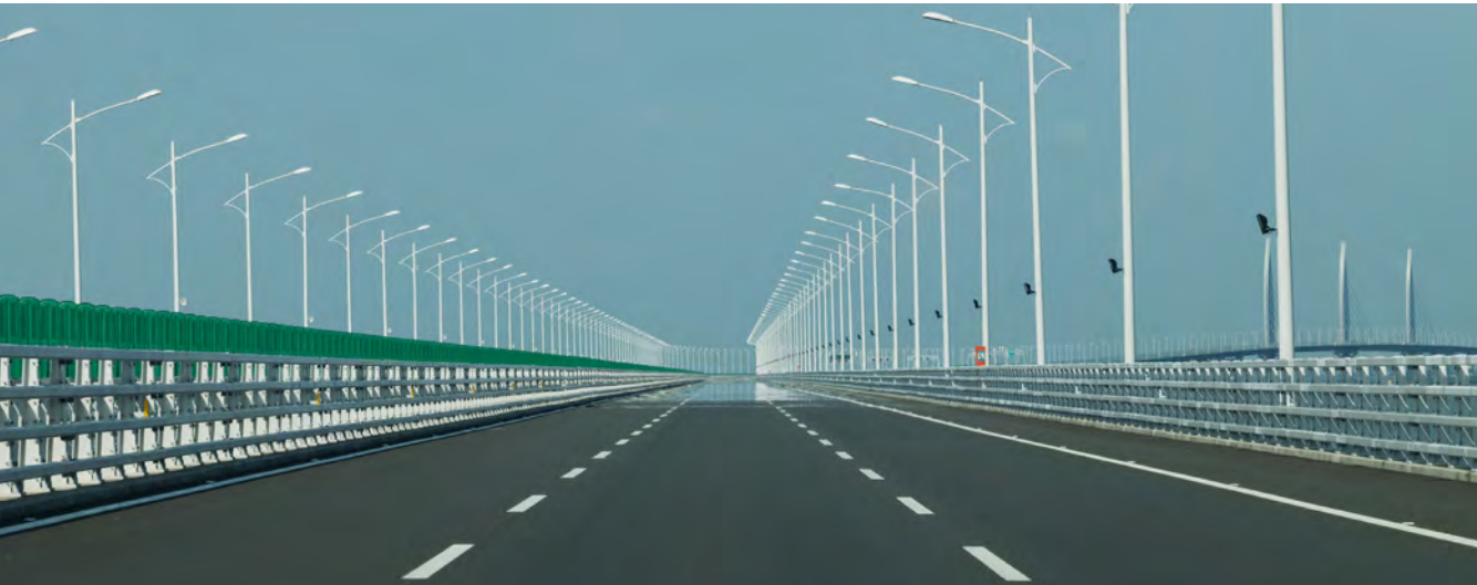
détail : LES NOUVELLES ROUTES DE LA SOIE. Hong Kong-Macau-Zhuhai bridge. Zhuhai, Guadong Prov. China, 2018 © Dominique LAUGÉ
